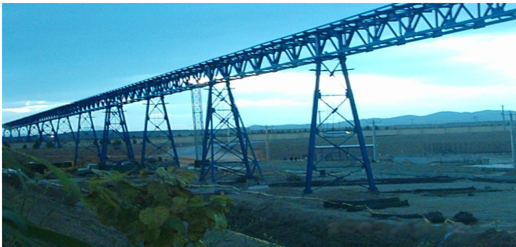
پروژه ساخت نوارنقاله کوره 3 ذوب آهن اصفهان (طرح توازن)
