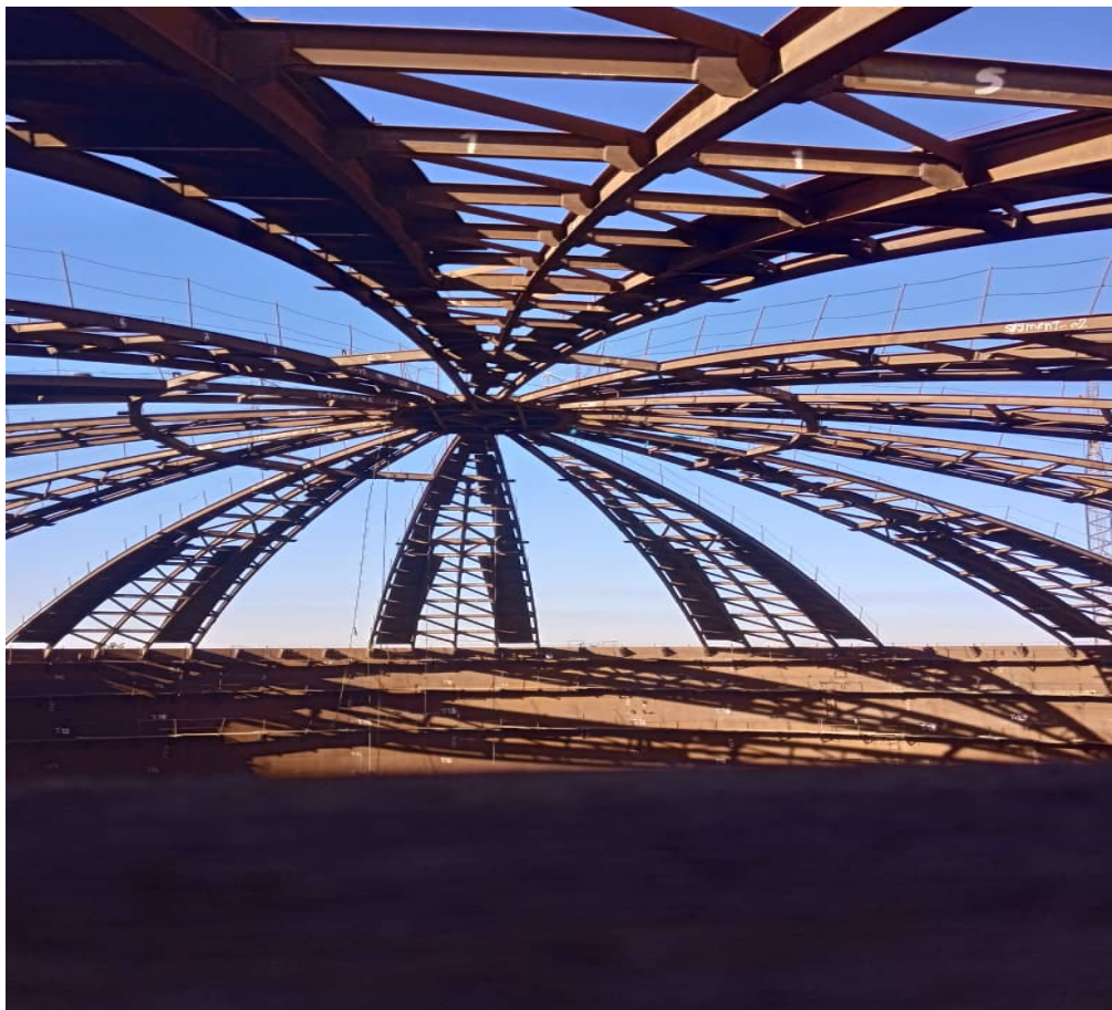
پروژه ساخت و نصب دو دستگاه مخزن ذخیره سقف شناور داخلی به قطر ۶۷ متر پتروشیمی مخازن سبز عسلویه
