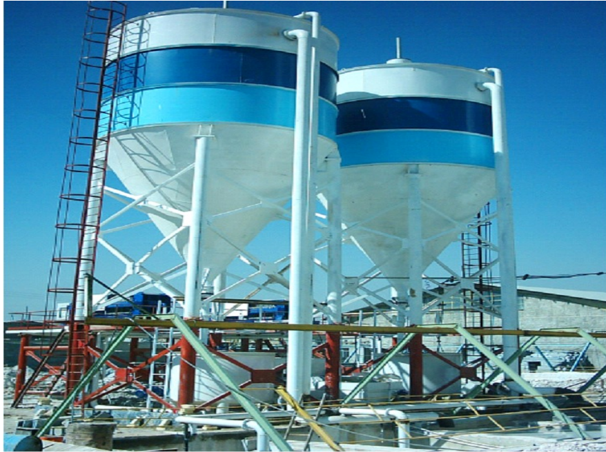
پروژه ساخت و نصب مخازن تصفیه شرکت احرار سپاهان
