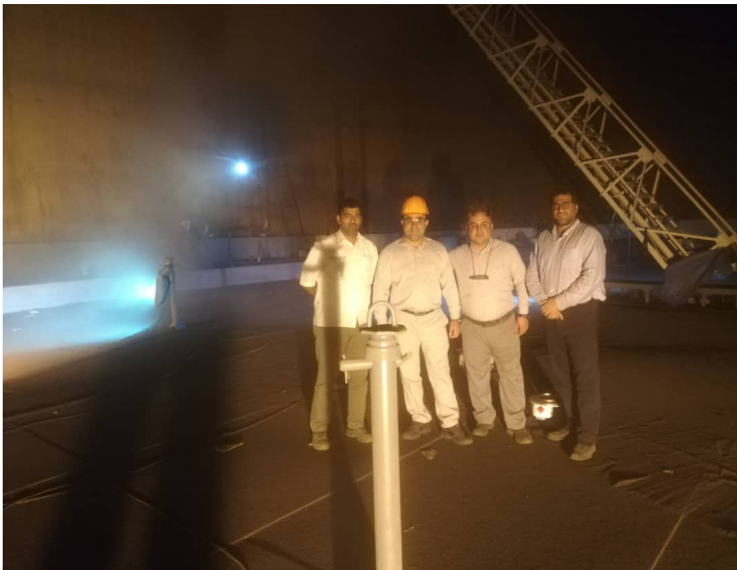
انجام تعمیرات اساسی مخزن سقف شناور 06 به قطر 57 متر - شرکت پایانه های نفتی خارک
