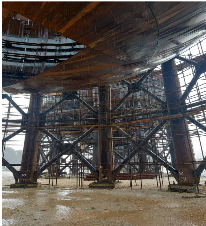
پروژه عملیات جوشکاری ۵ دستگاه مخزن کروی کربن استیل پتروشیمی کیان - عسلویه
